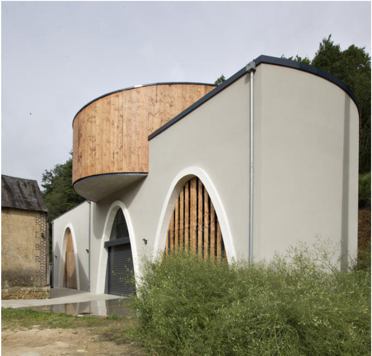
Lhomme, Bellivière : chai de vinification (2015) par Gilles Poulain, architecte à Flée.
