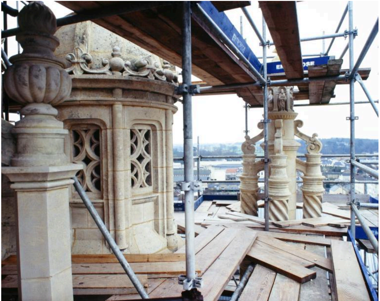
Basilique, clocher : tambour du lanternon et pinacle sud ouest.
