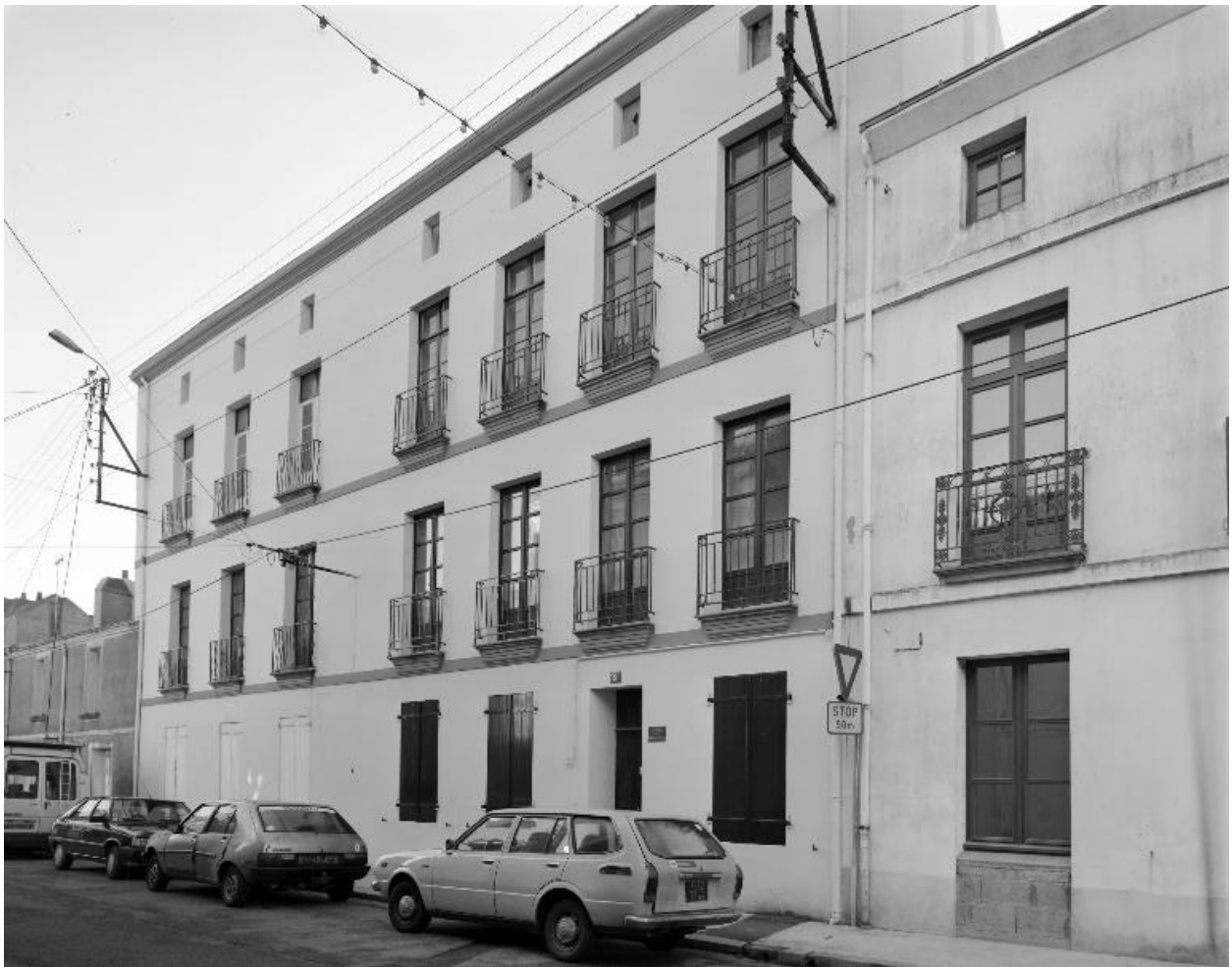
Maison, 9 rue Pierre-Jubau.
