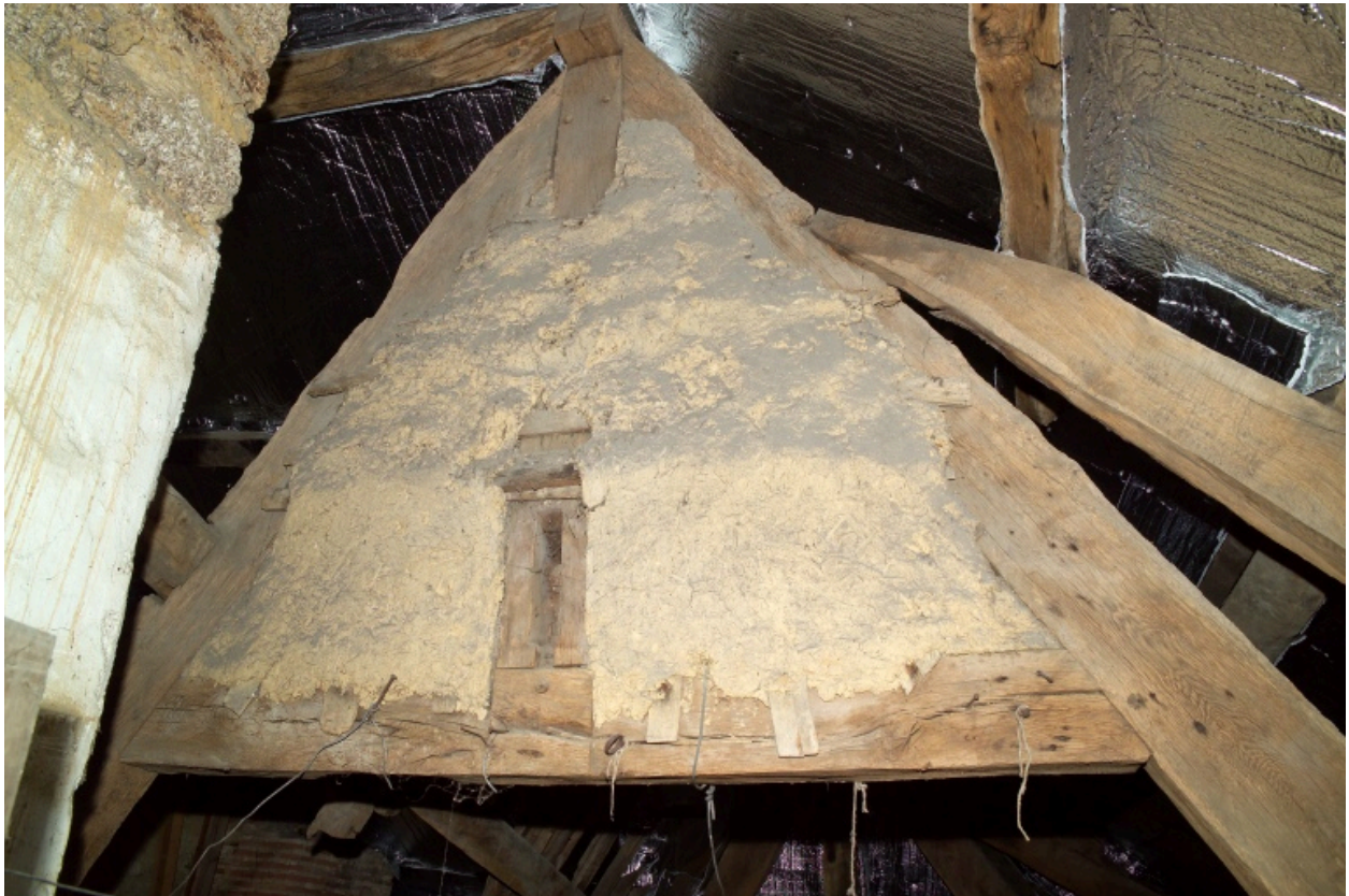
Charpente de la partie arrière, détail.
