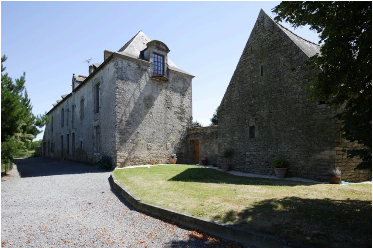
Logis. Vue d'ensemble depuis le nord-ouest.
