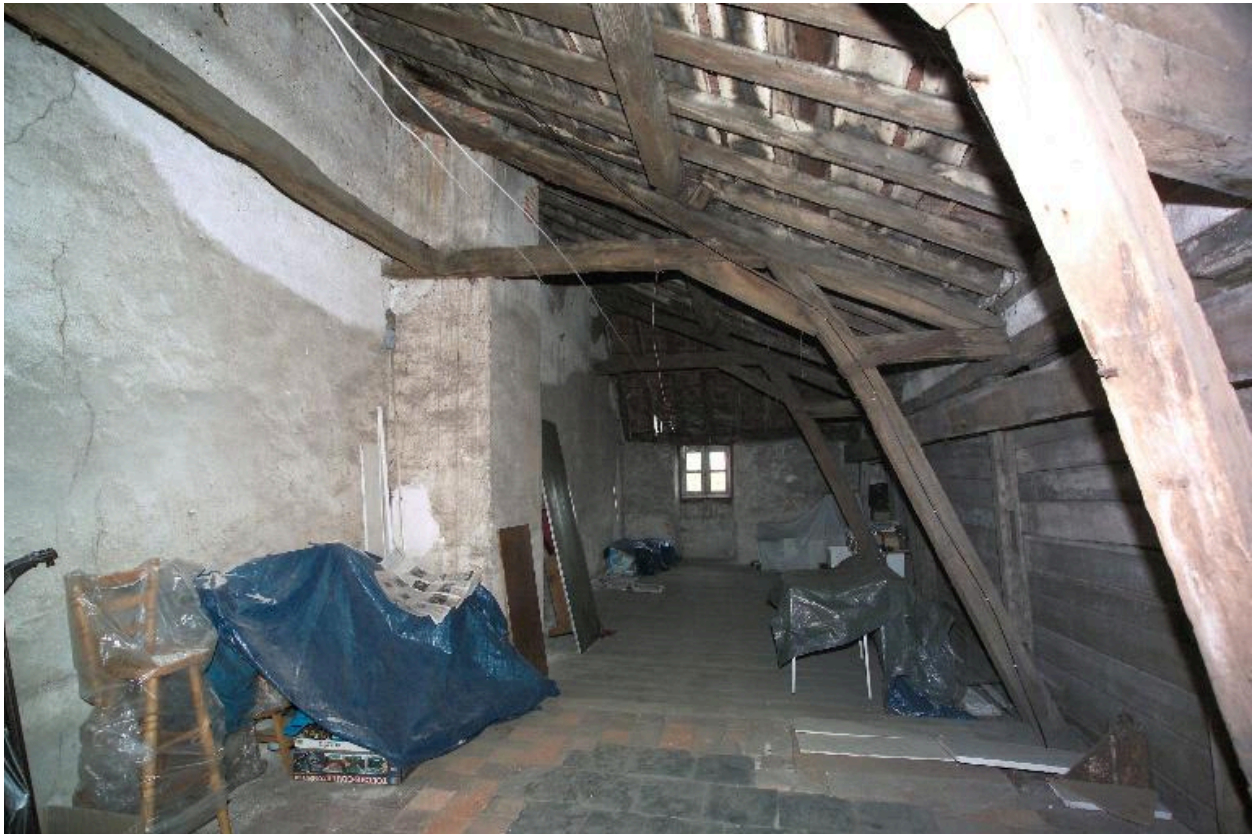
L'étage de comble vu de la Loire vers la rue.
