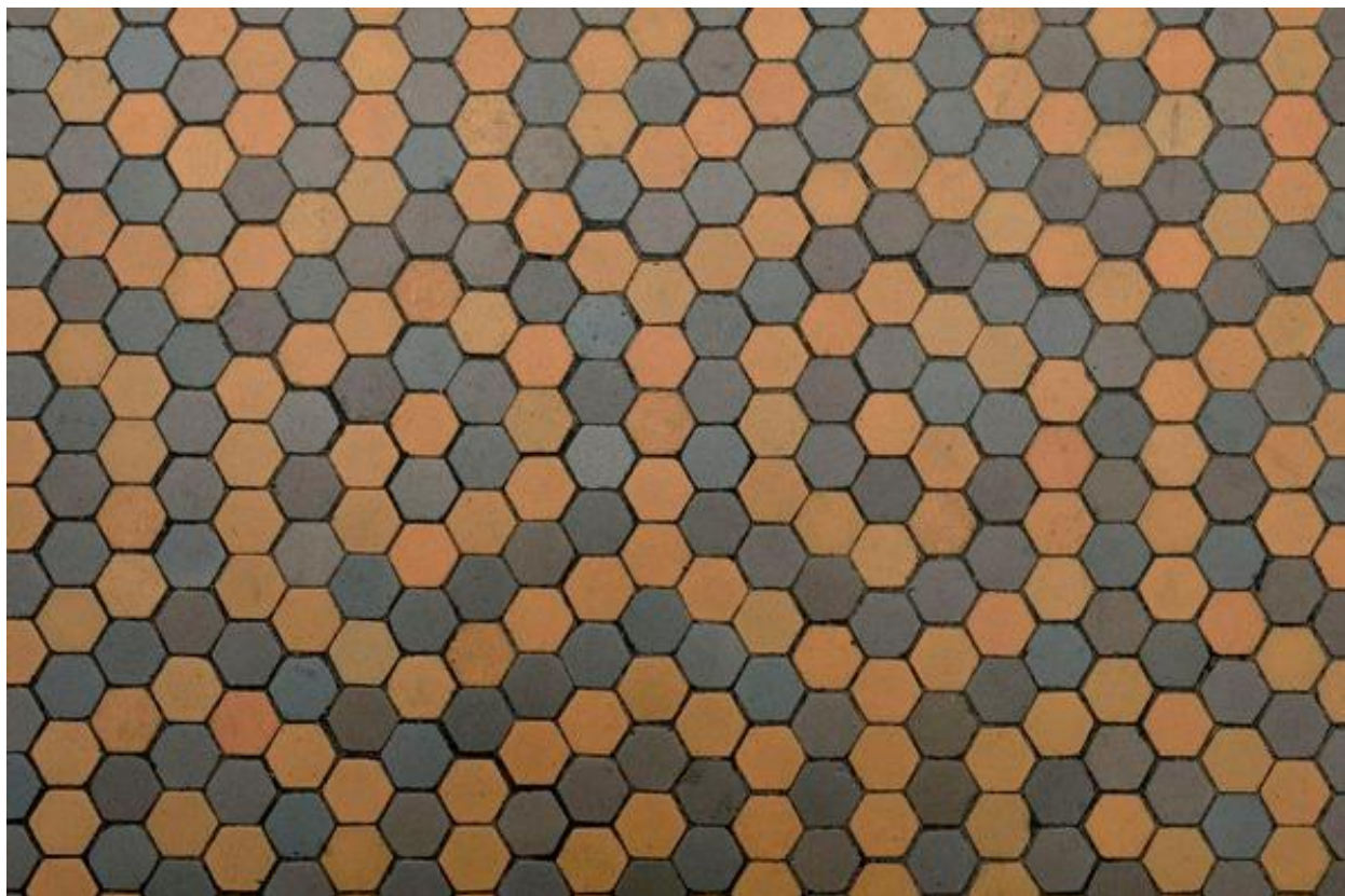
Détail du carrelage.
