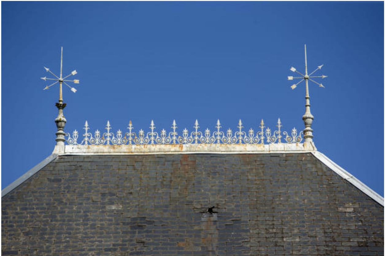
Un détail d'une crête de faîtage de la fin du XIXe siècle, avenue de la Gare.
