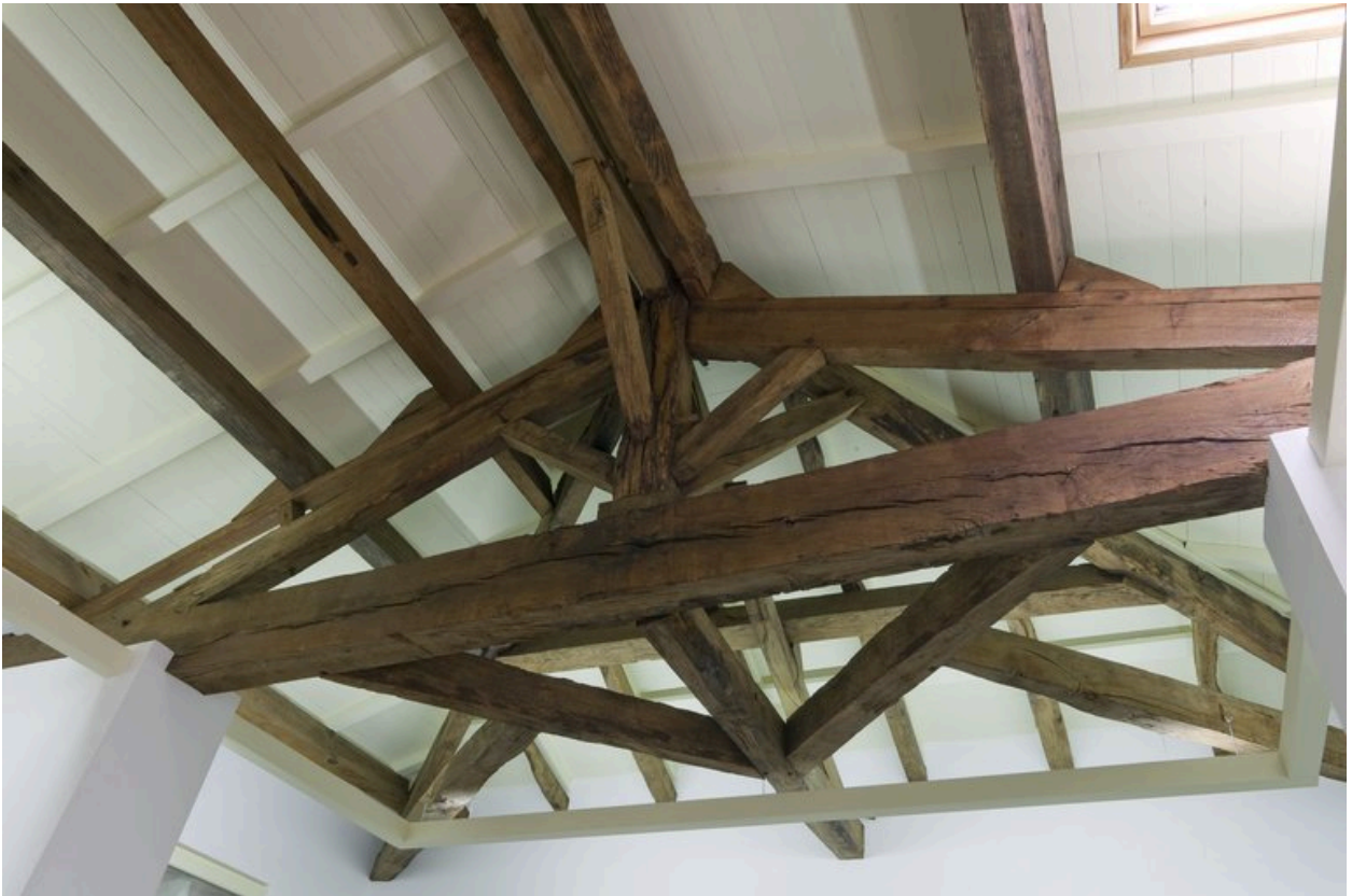
Vue de la charpente des dépendances.
