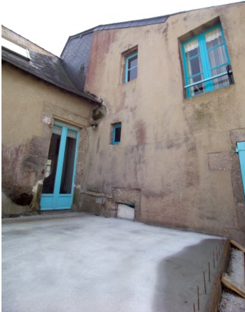
Détail de l'adjonction sud avec les petites fenêtres de la cage d'escalier.
