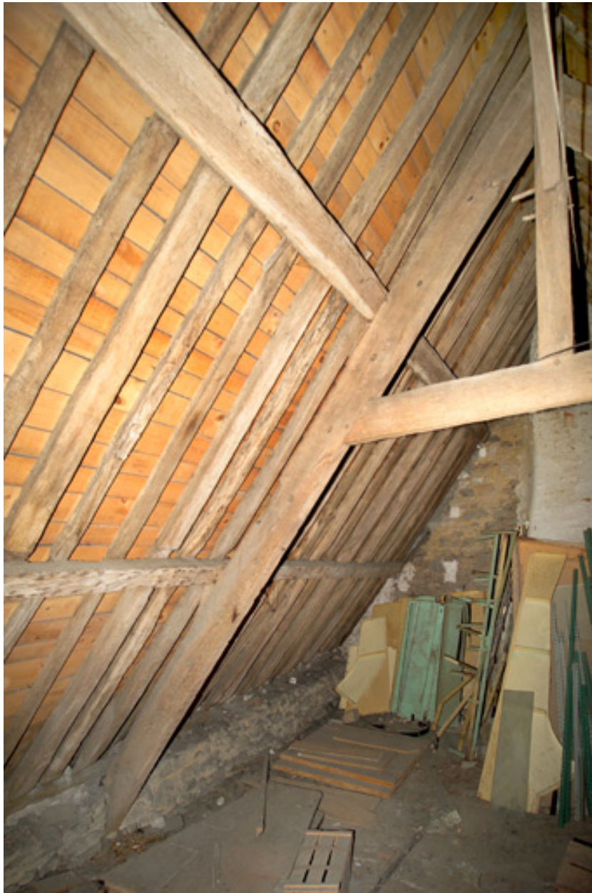
Corps principal, combles, détail de la charpente.
