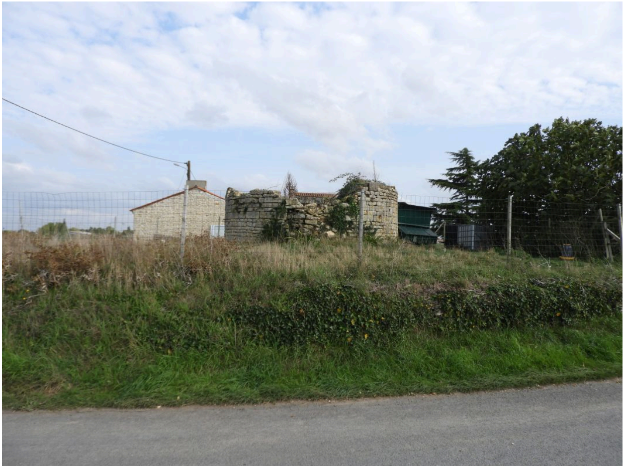
Les vestiges du moulin et son cerne, vus depuis le nord-ouest.
