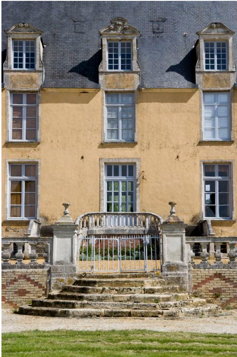
Détail de l'élévation sud du corps central du logis.
