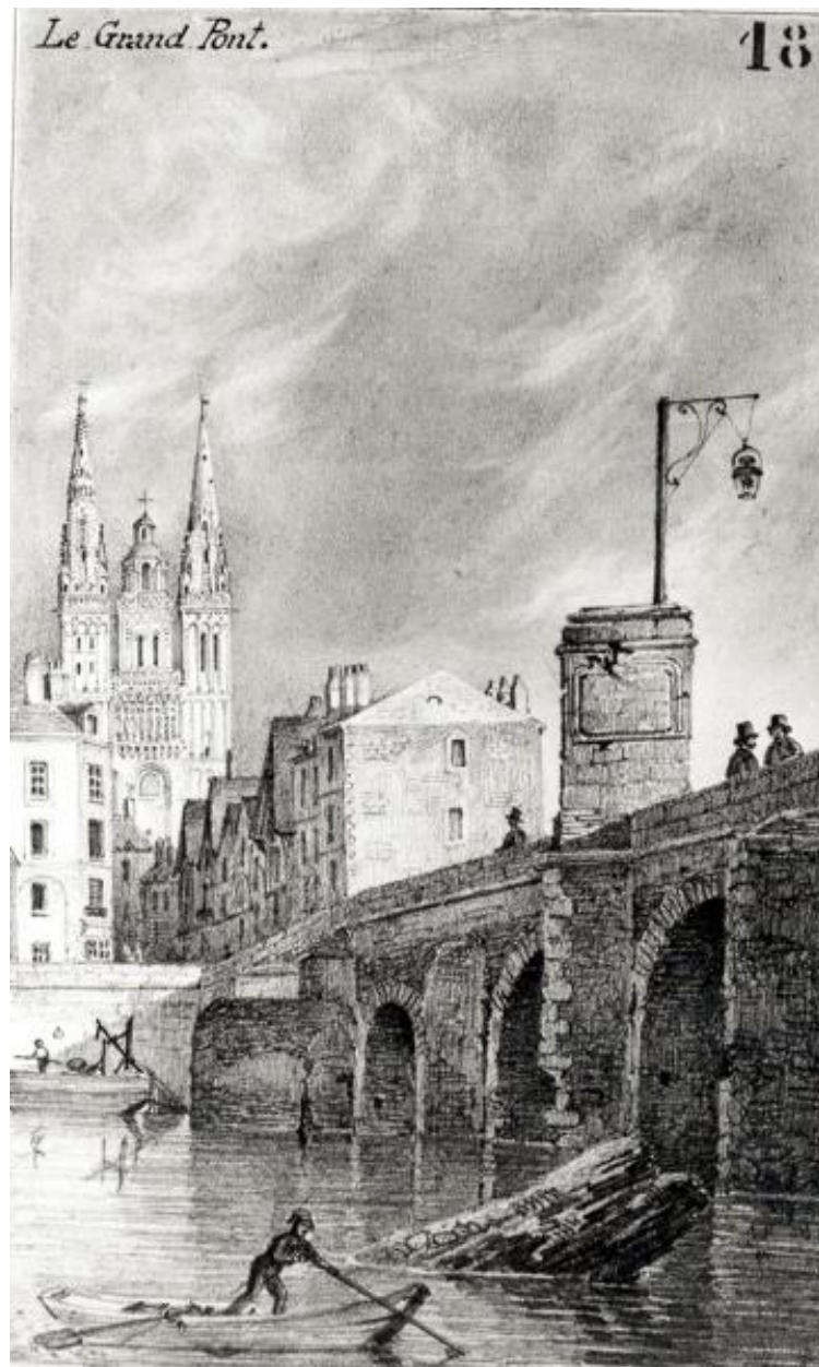
Le Grand pont : élévation amont depuis la rive droite, par F. Benoist, [av. 1843]. (Musées d'Angers ; MBA 76.33.18, inv. Labalte 492).
