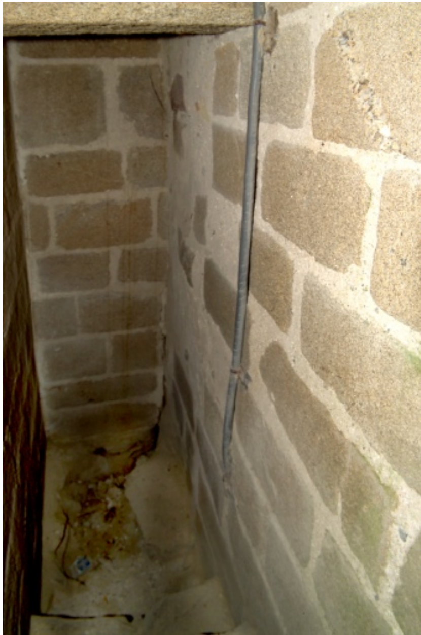
Partie basse de l'escalier droit intra mural ; ancienne porte d'accès à droite.
