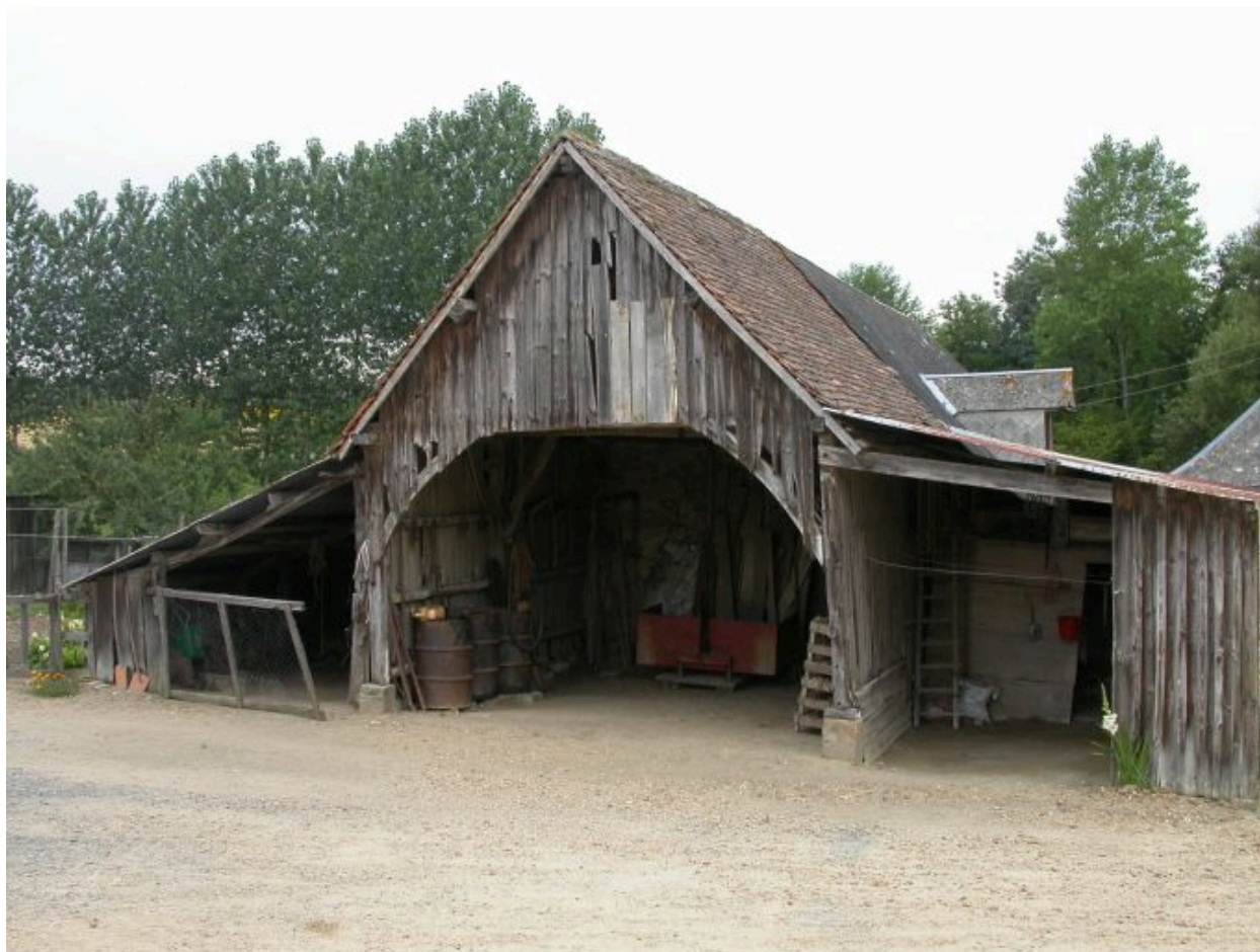
Hangar en charpente couvert de planches.
