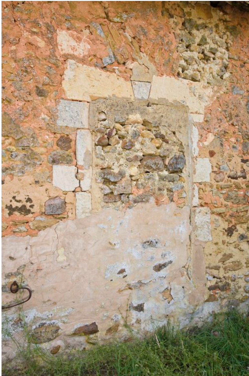
Détail de l'élévation antérieure de la grange-étable : porte de l'étable.
