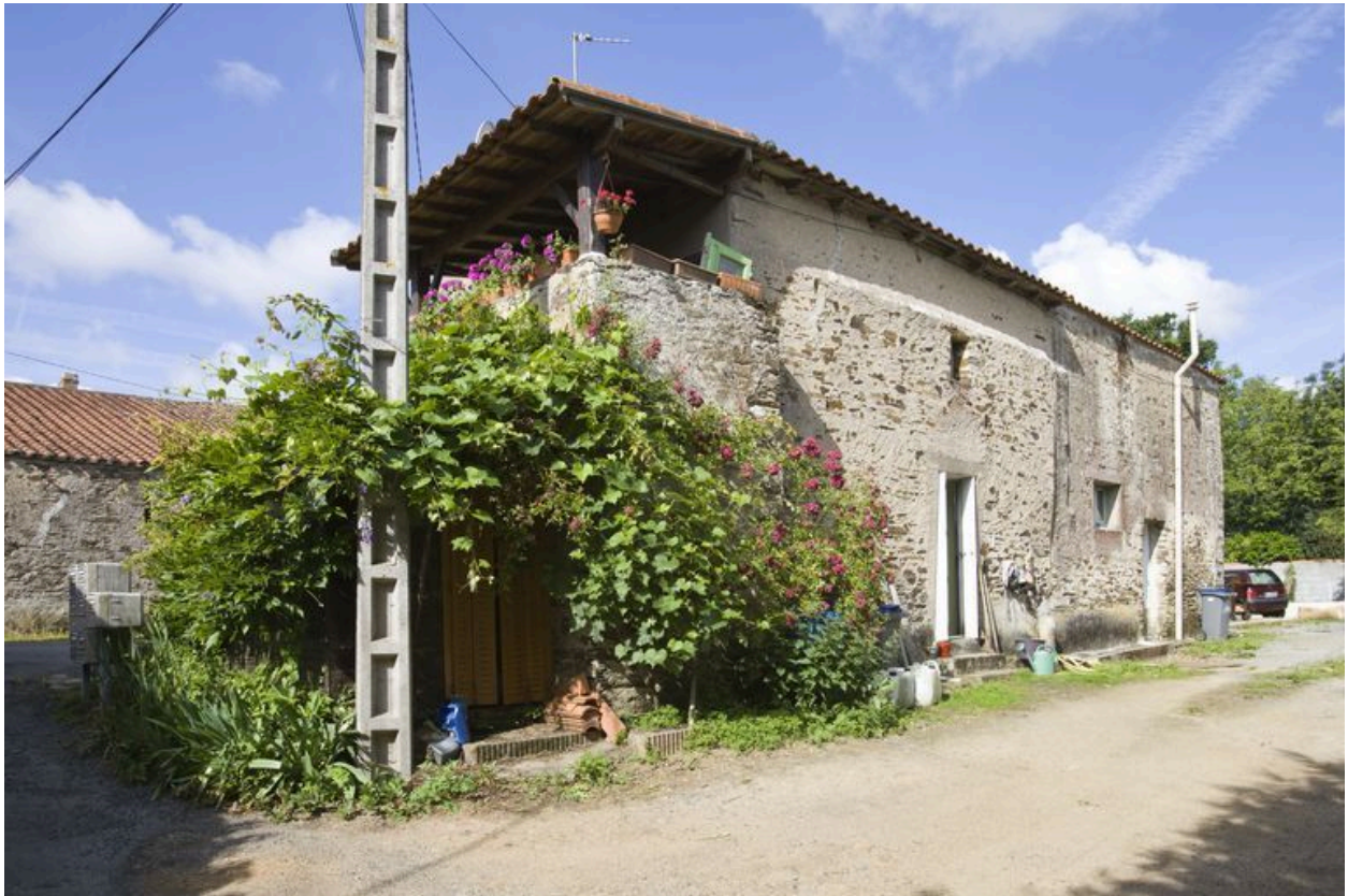
Maison de vigneron, 18e siècle, remaniée au 19e siècle : élévation nord.
