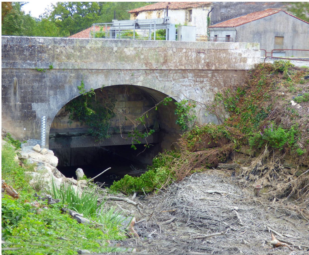
Août 2020 : l'aqueduc en cours de dégagement, vu depuis l'aval.
