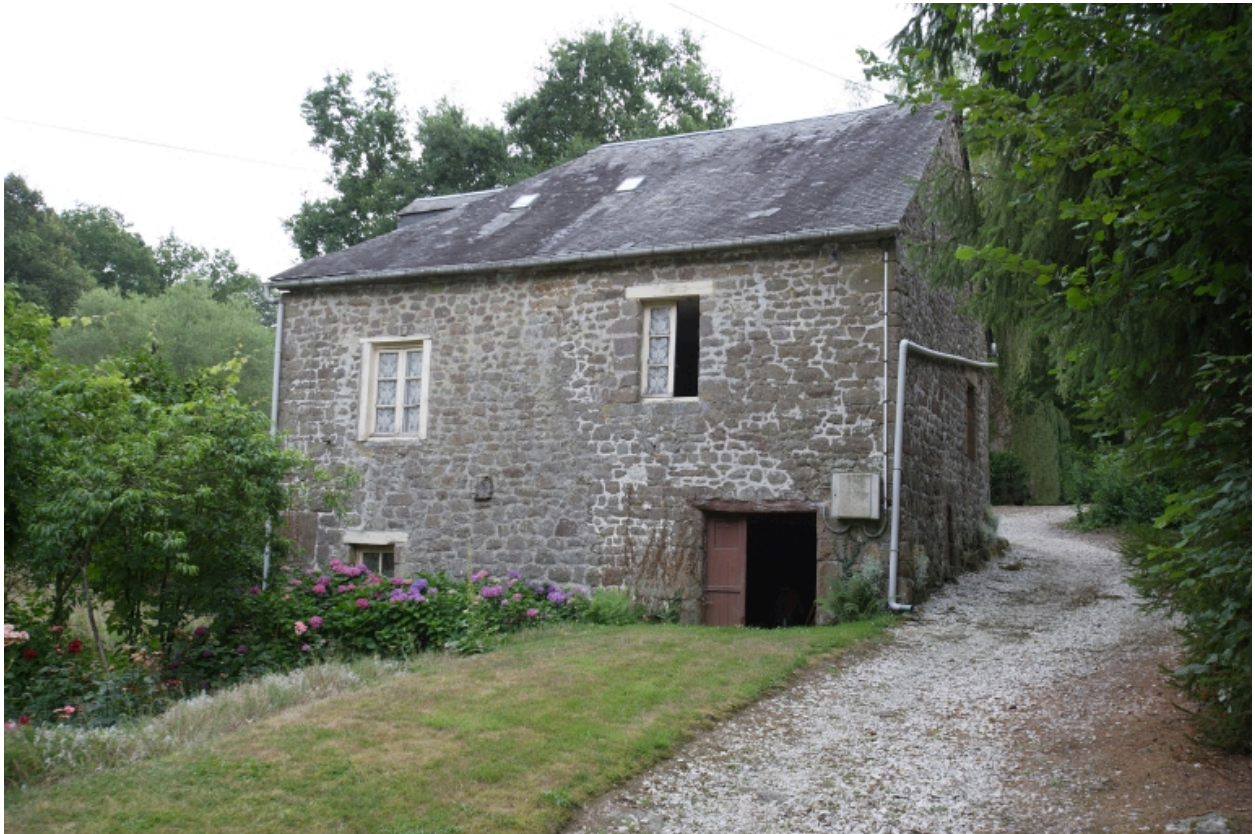
Le moulin à farine sur le ruisseau : élévation nord.
