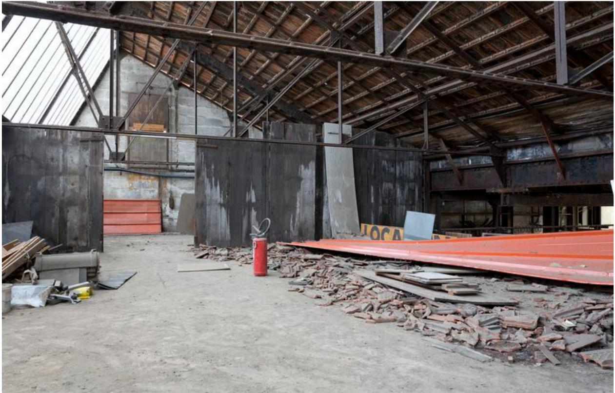
E : charpente métallique et couverture en sheds.
