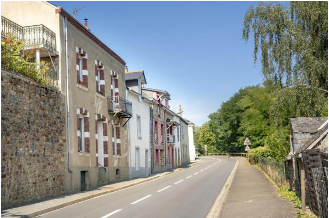
Des maisons de bourg face à la Mayenne.
