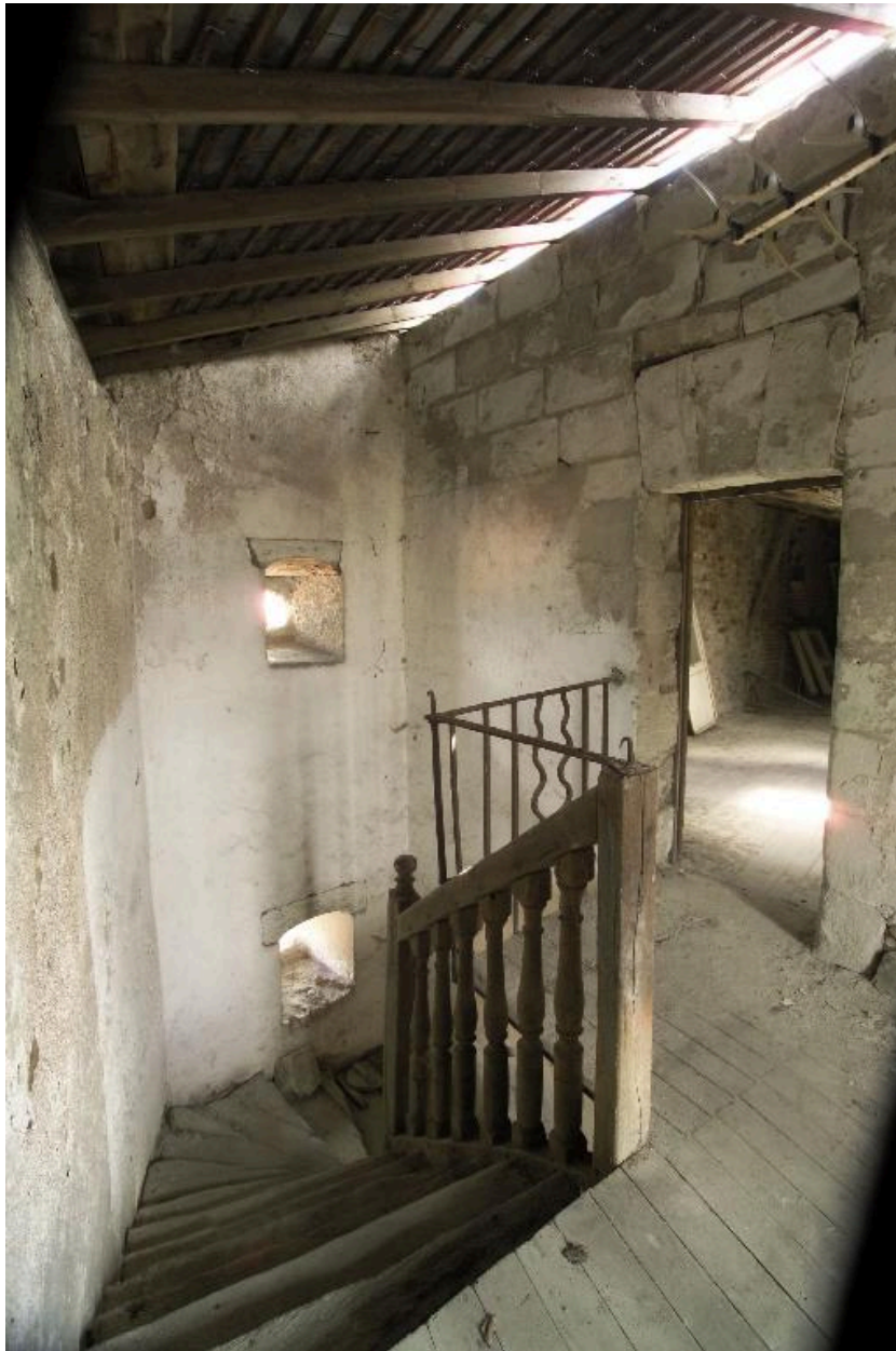
L'escalier, vue prise du dernier palier vers le corps secondaire.
