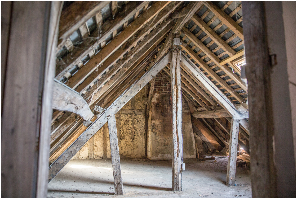
Un intérieur valennois, comble et charpente.
