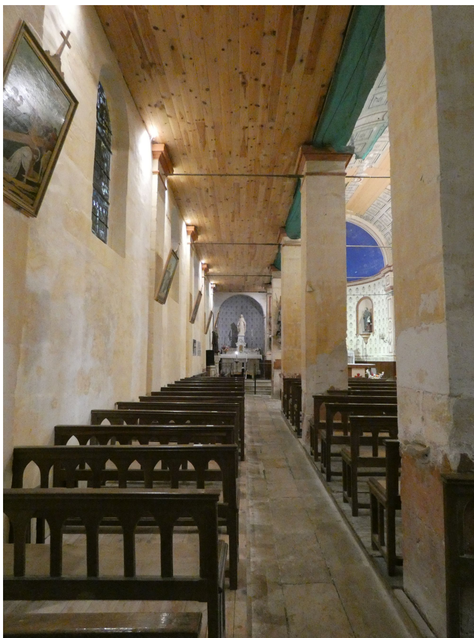
Le bas-côté nord vu depuis l'ouest.
