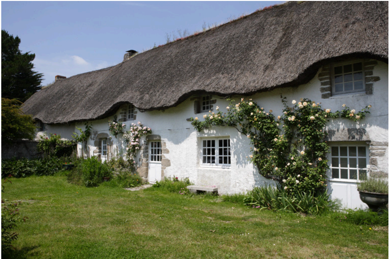
Vue de la façade sud de la rangée depuis le sud-est.
