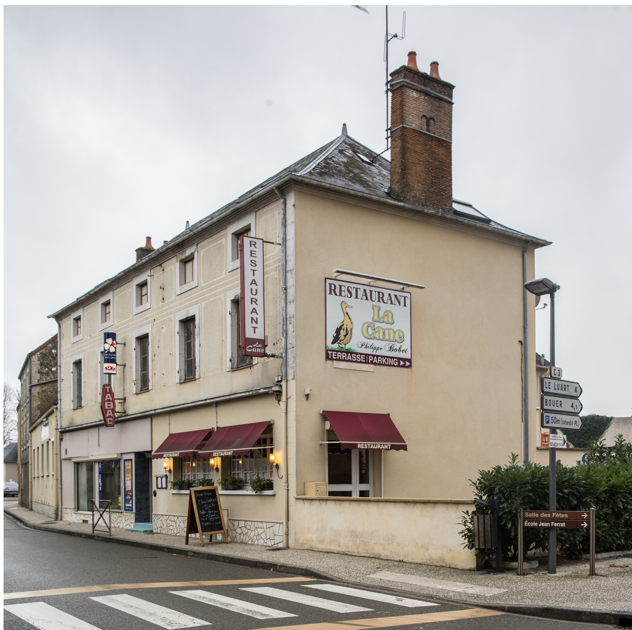
Le bâtiment principal.
