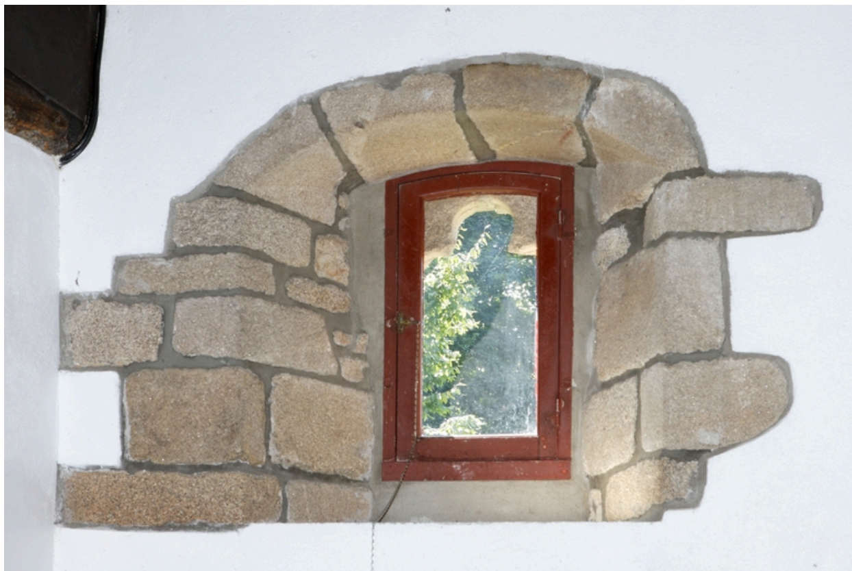
Vieux logis. Salle nord. Rez-de-chaussée. Ébrasement de la baie trilobée.
