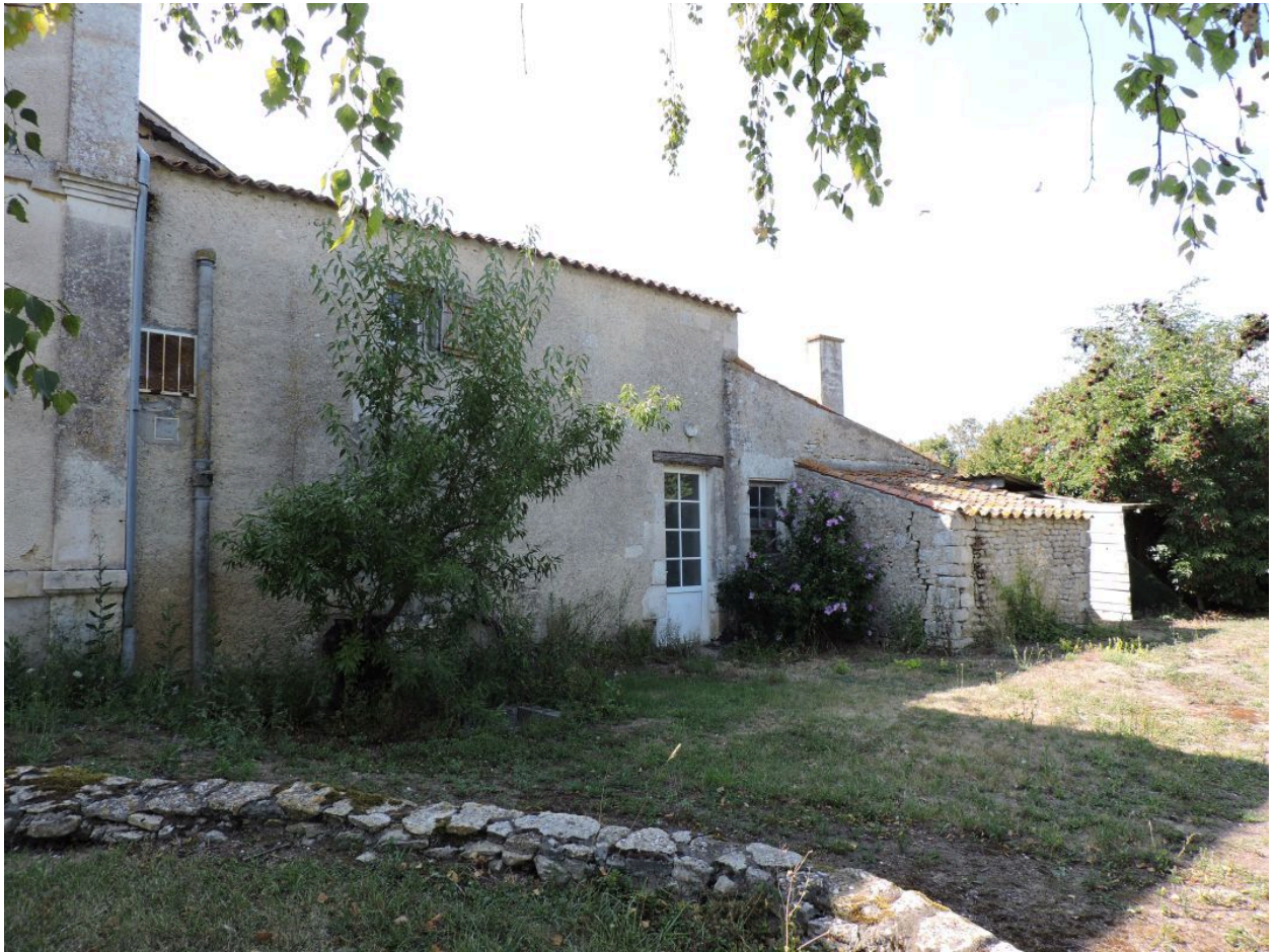
L'ancien logement vu depuis le sud-est, avec le fournil.
