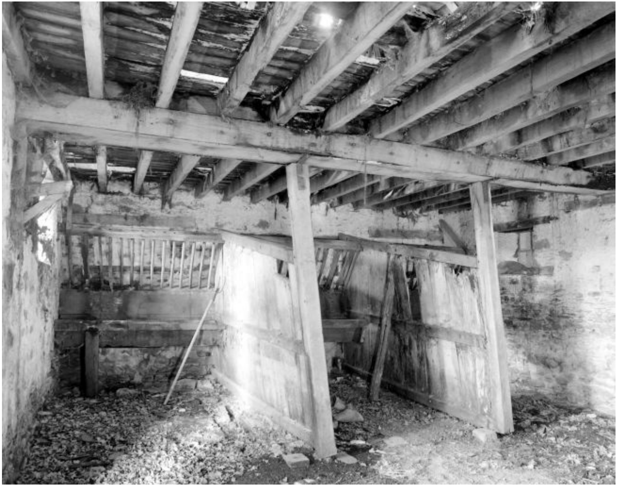
L'étable à chevaux, en 2002 : les stalles adossées au mur nord-est.
