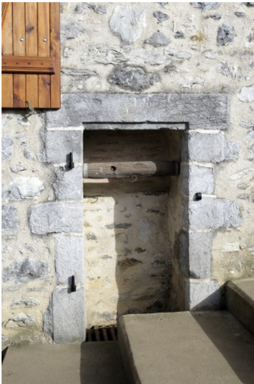
Détail de la façade du logis-écurie : le puits.
