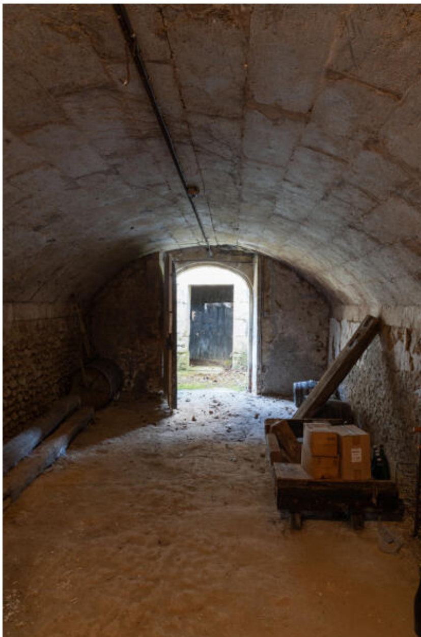
Cellier semi-enterré : vue de l'intérieur.
