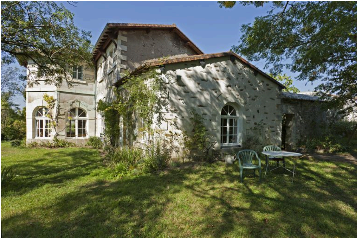
La dépendance sud, vue de l'est : le pavillon anciennement à usage de boulangerie.
