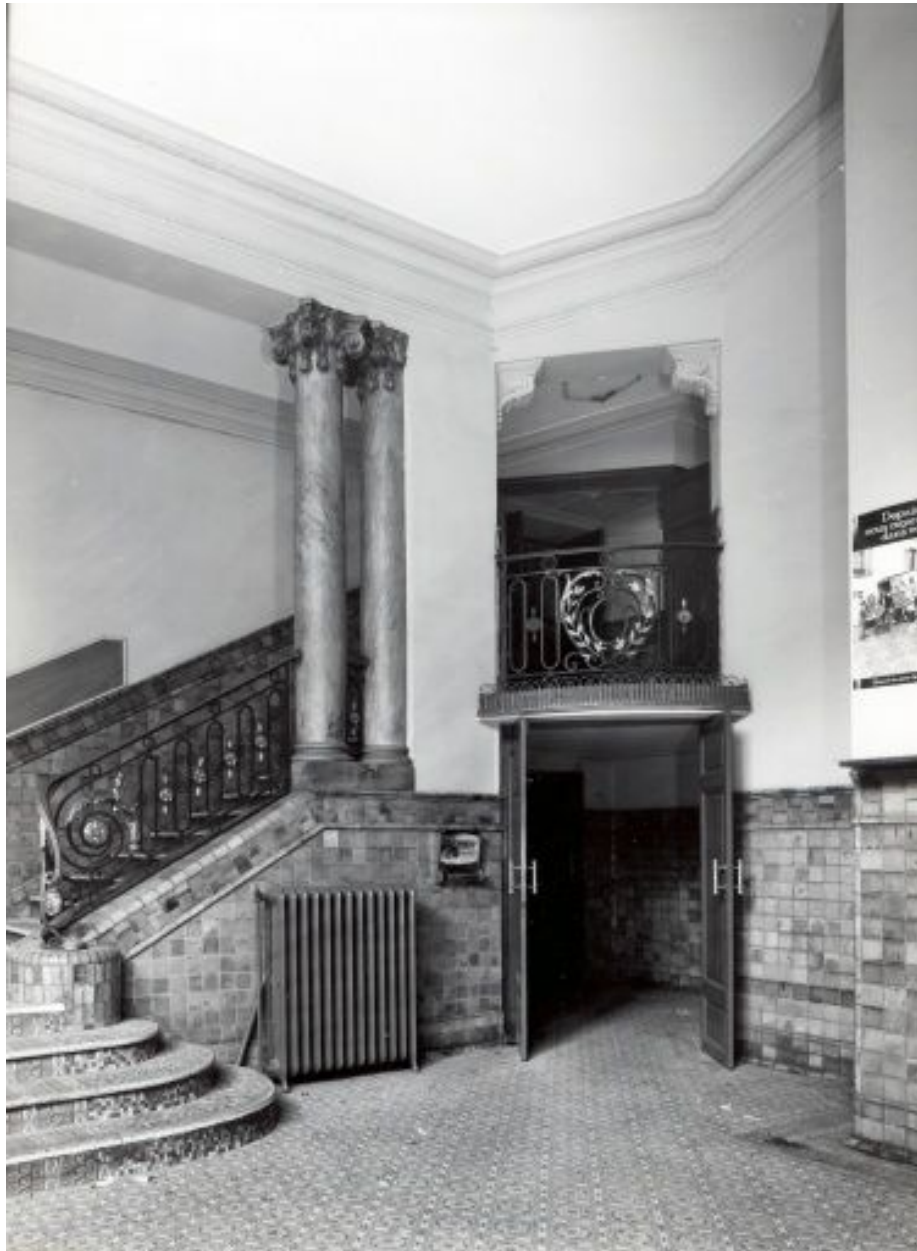
Vestibule, angle nord-ouest.
