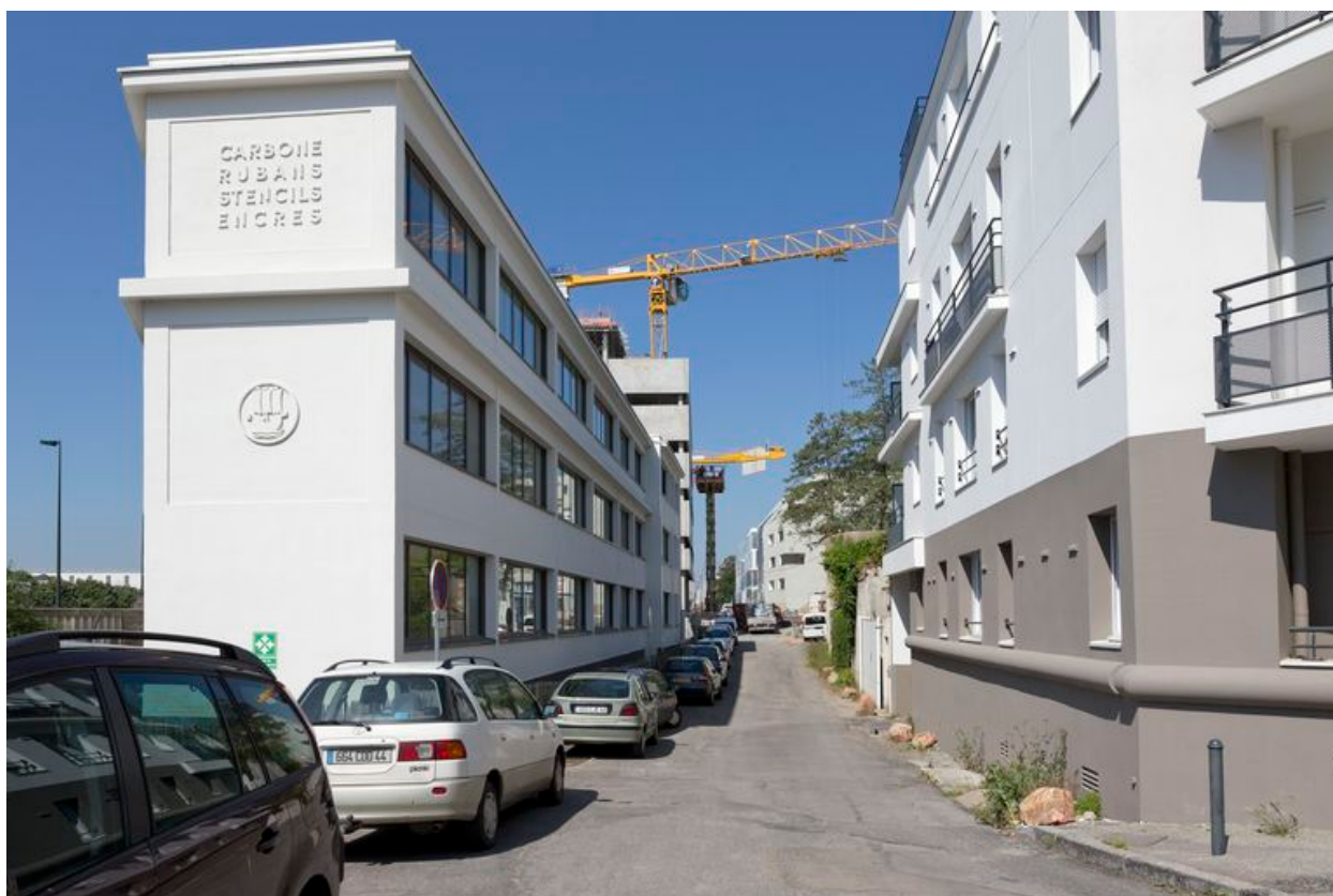
Pointe d'Armor réhabilitée, 2013.
