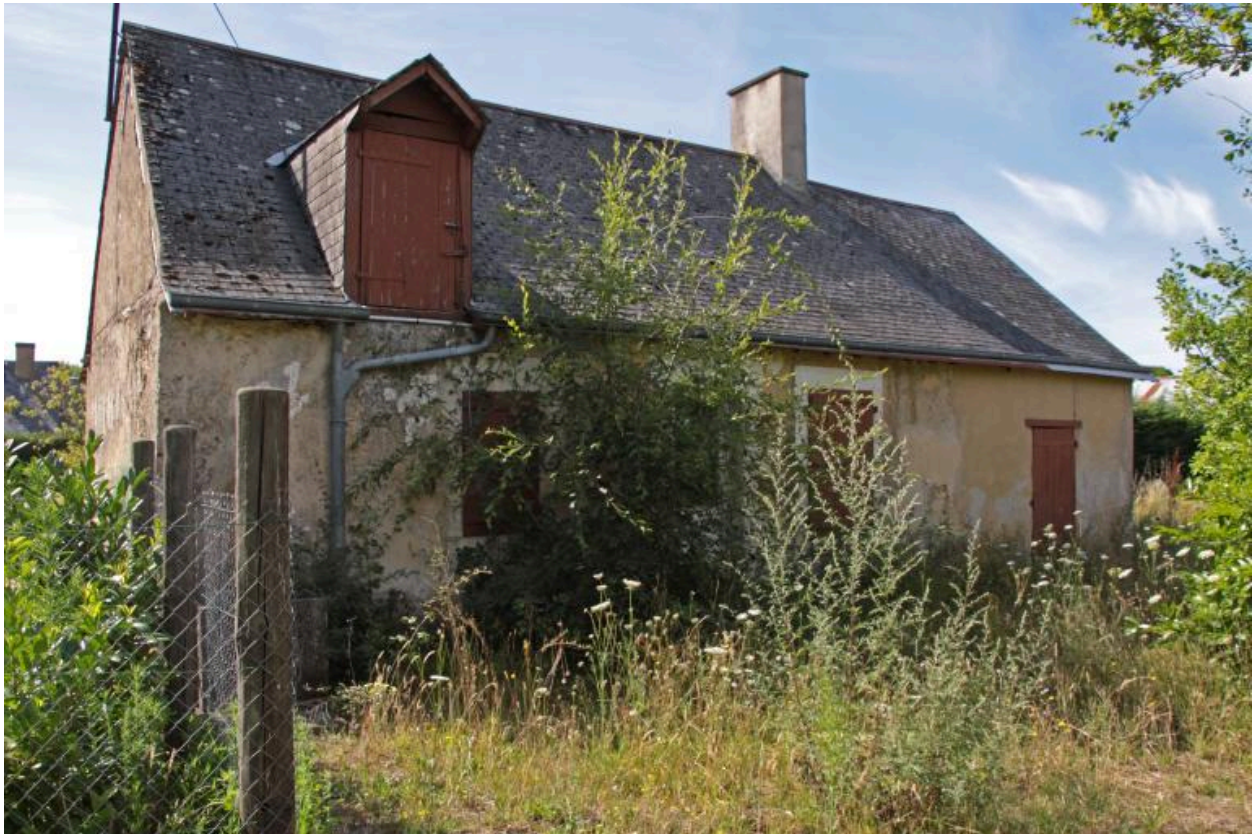
Maison n°13 : façade antérieure sur cour placée au nord.
