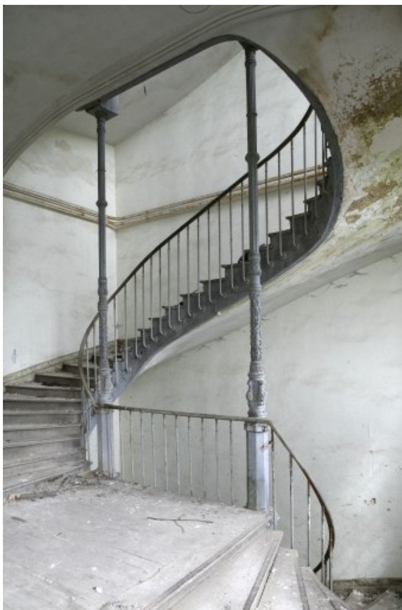
Intérieur du bâtiment principal : deuxième volée de l'escalier.
