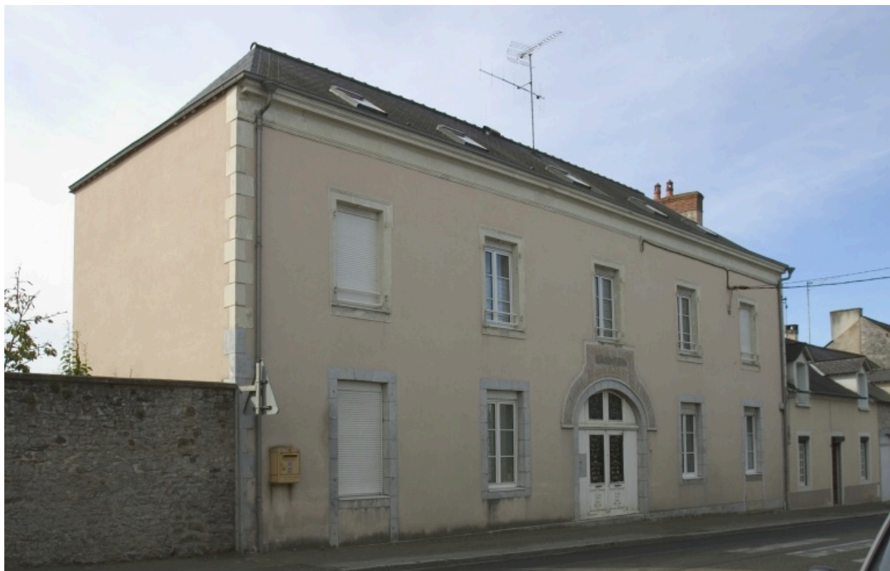
Le corps de bâtiment sur rue.
