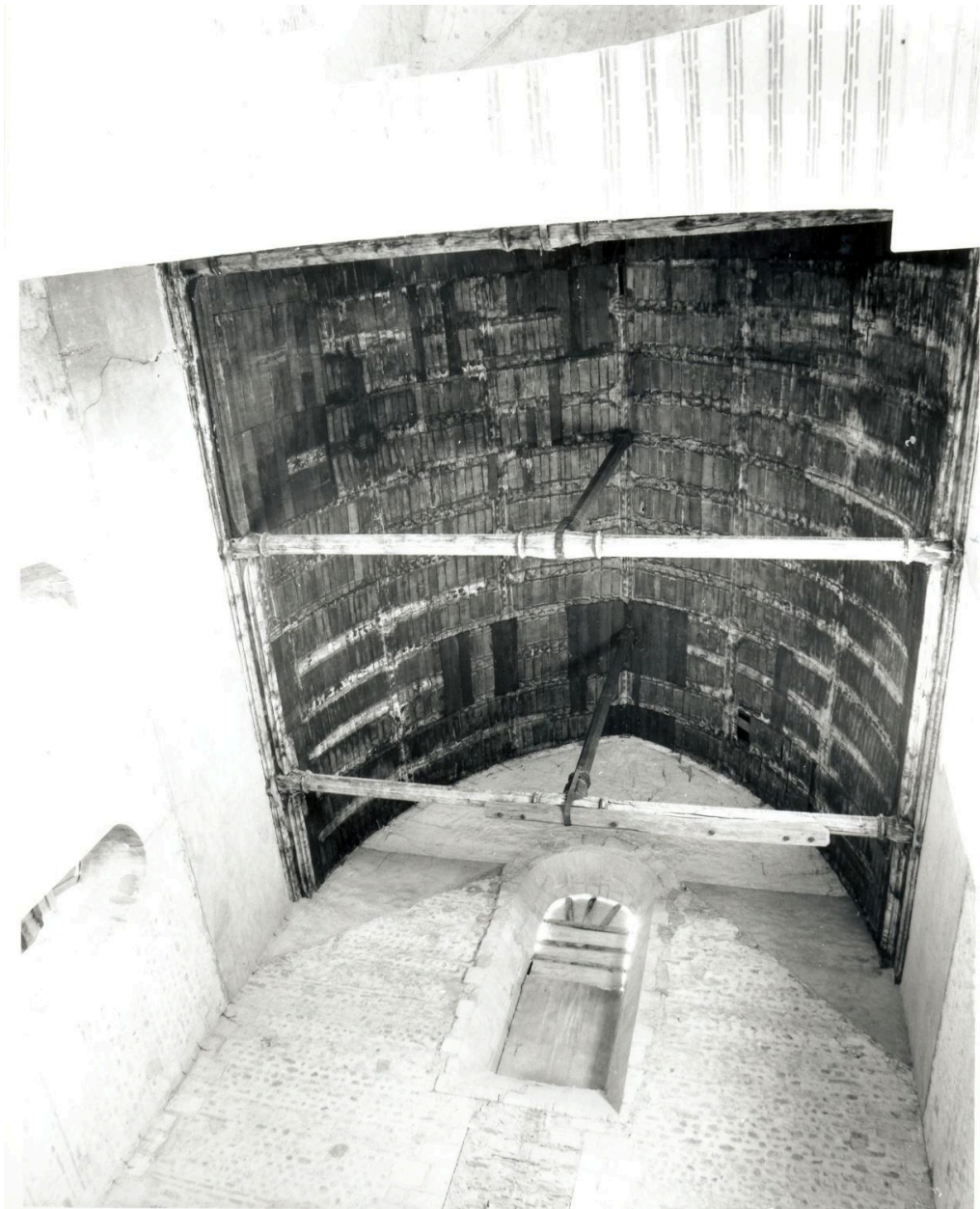
Collégiale Saint-Martin, croisillon sud du transept, vue vers le pignon sud : charpente lambrissée en berceau brisé.
