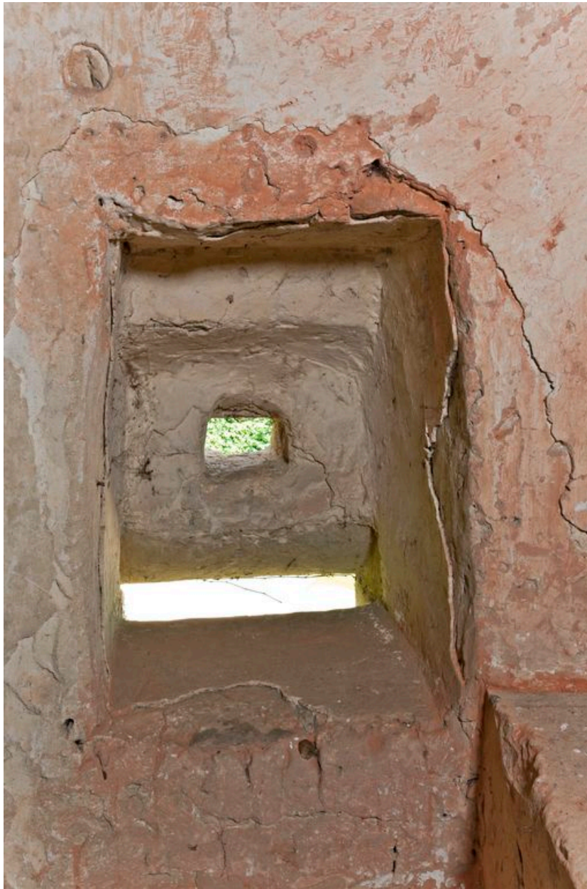
Vue intérieure de la meutrière de fusillade de la tour d'escalier.
