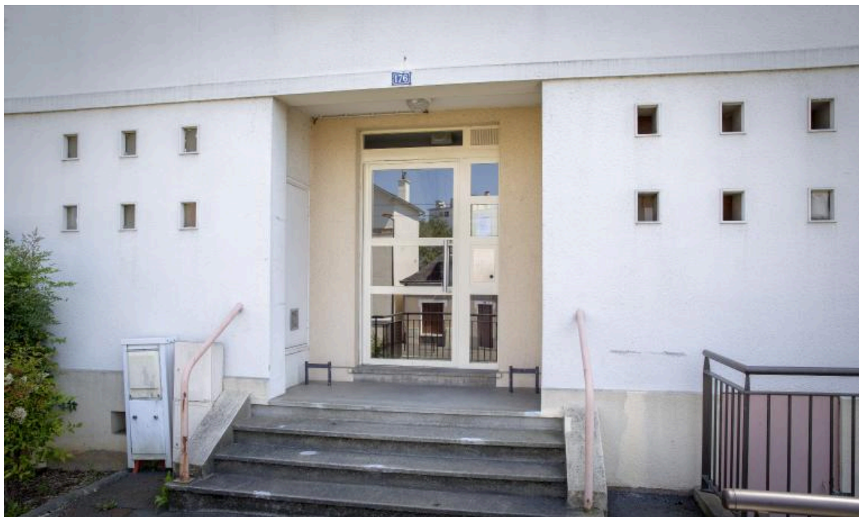
Détail de l'entrée de l'immeuble 176 rue des Maillets.
