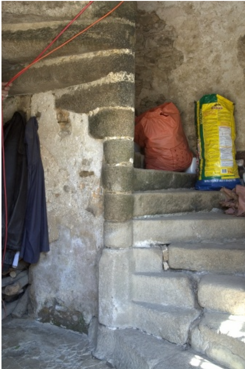
Intérieur du logis. L'escalier vu depuis le rez-de-chaussée.
