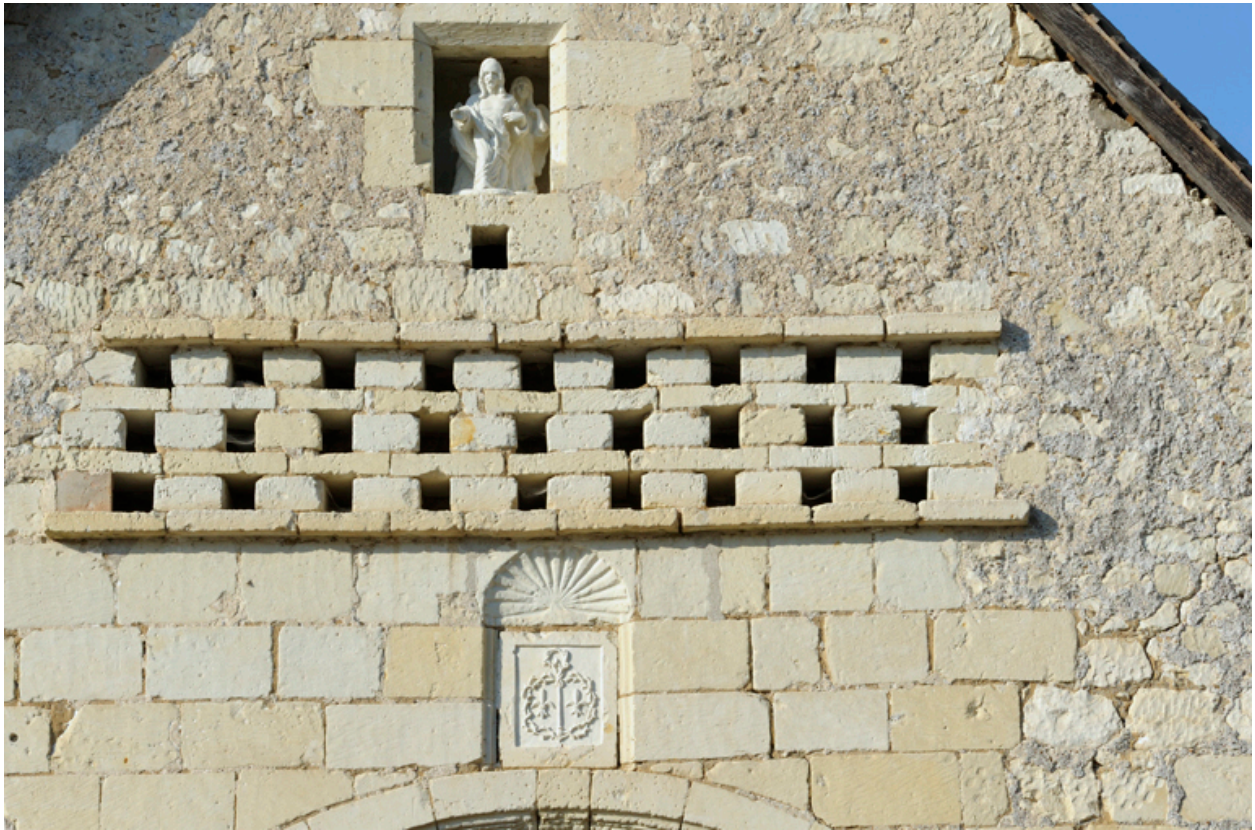
Grange, détail de la façade, avec baie chanfreinée à congés et pigeonier.
