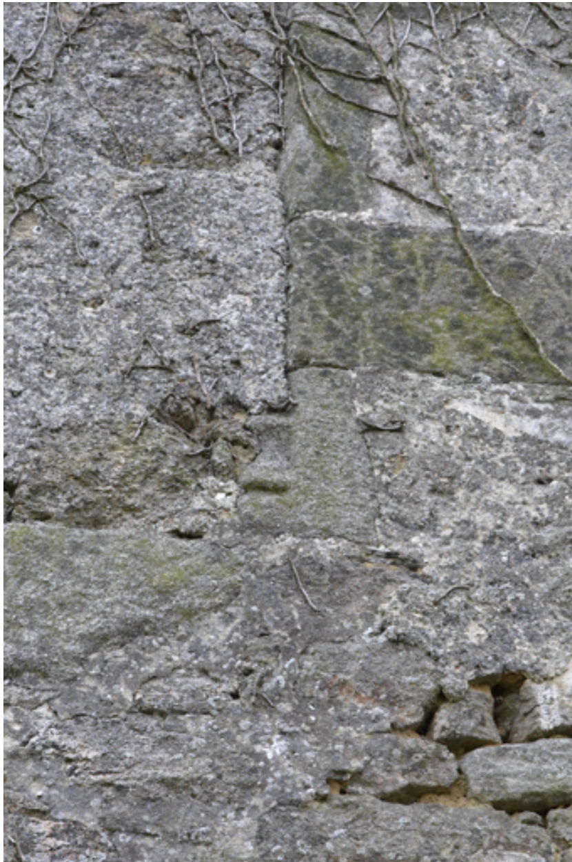
Logis. Façade nord. Détail de la base du piédroit de la croisée au 2e niveau de la 2e travée.
