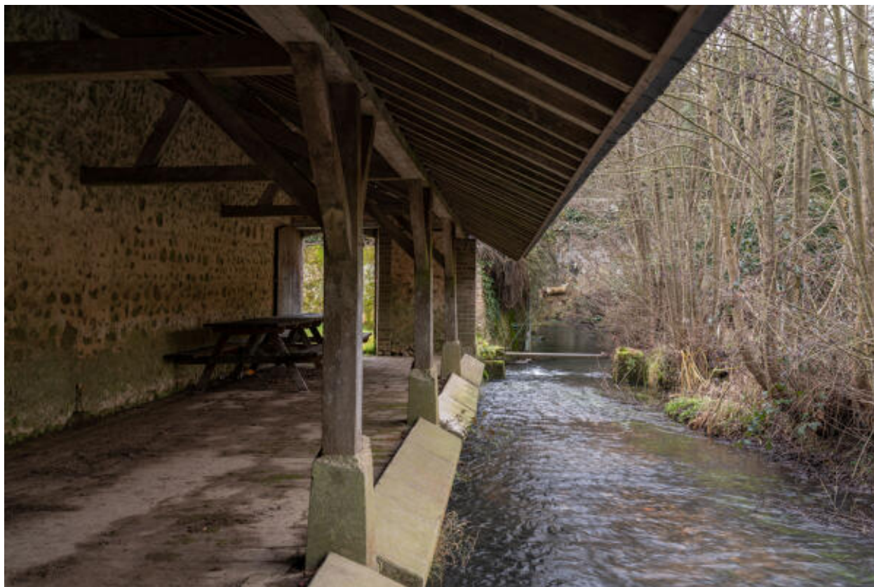
L'intérieur du lavoir et le cours d'eau avec la vanne en arrière-plan.
