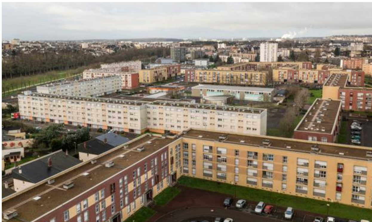
Vue des immeubles Vergraud avec l'école centrale.
