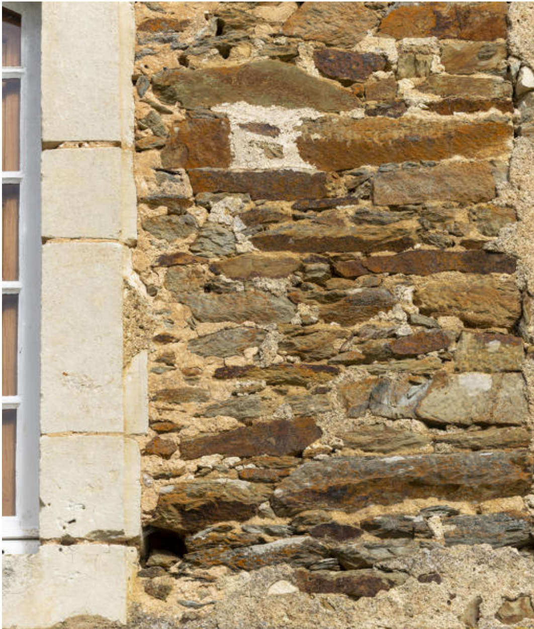
Un détail de la maçonnerie.
