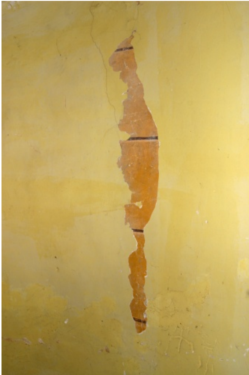
Détail du mur de la cage d'escalier : décor de faux appareil.
