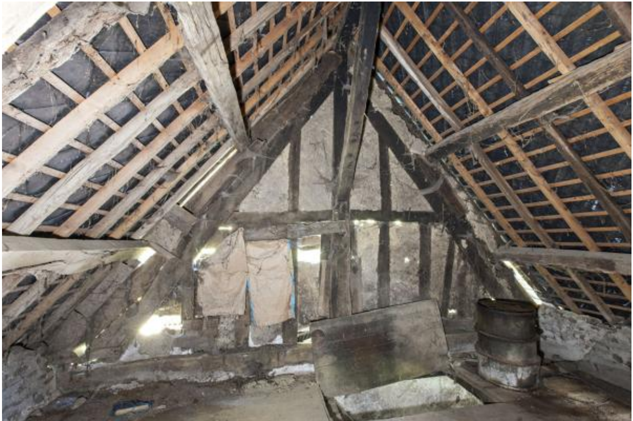
Pignon nord du logis nord.
