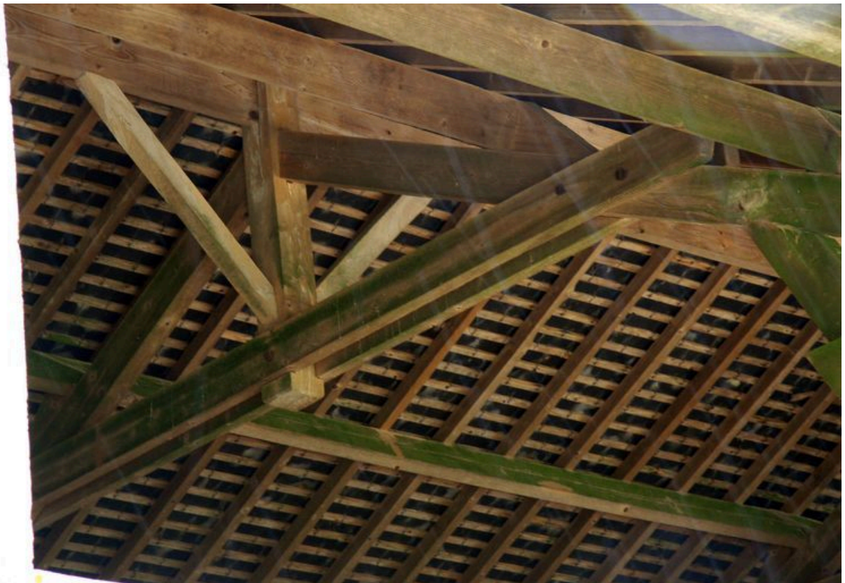
Les étables et fenils : charpente.
